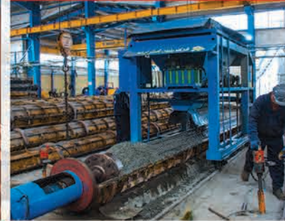
تولید بتن - بتن ریزی - پیش تنیدگی
