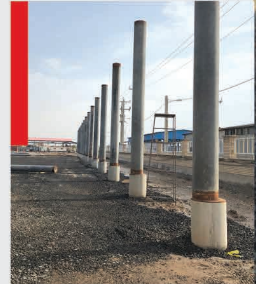
شمع - ستون بدون نیاز به فونداسیون
